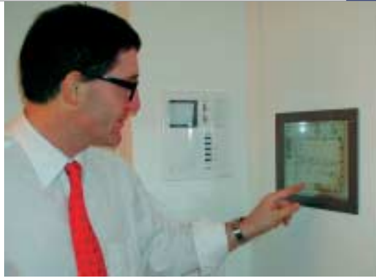
Komfortable Bedienung der gesamten Haustechnik über zentralen Touch-Panel. (Bild: BUS-House)
