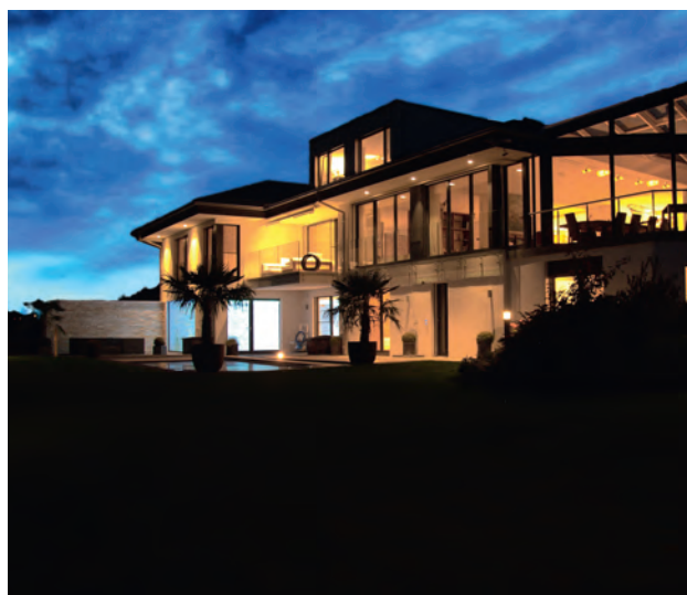
Eclairage extérieur et intérieur sont sources de redécouverte continue de la maison. (Source: Omalix)
