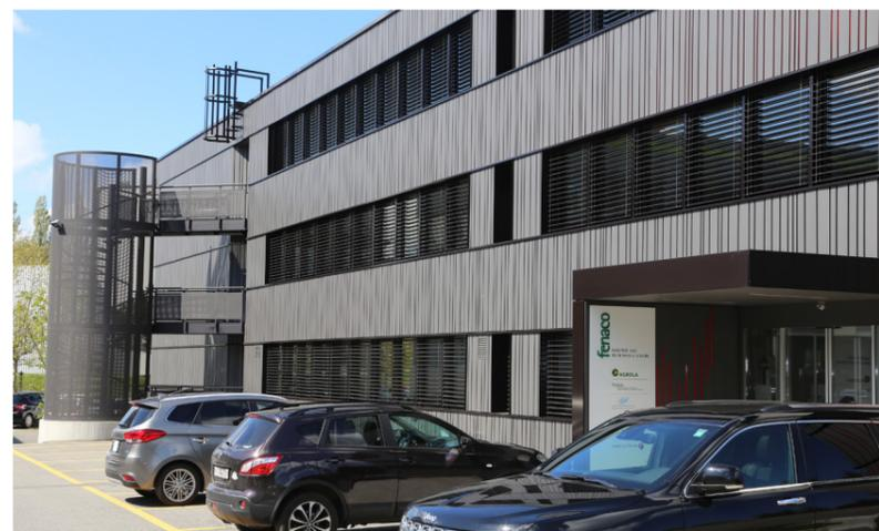
*Die Sanierung der Fassade und die Effizienz des Sonnenschutzes, haben eine Wärmeenergieeinsparung von 50 % ermöglicht*
