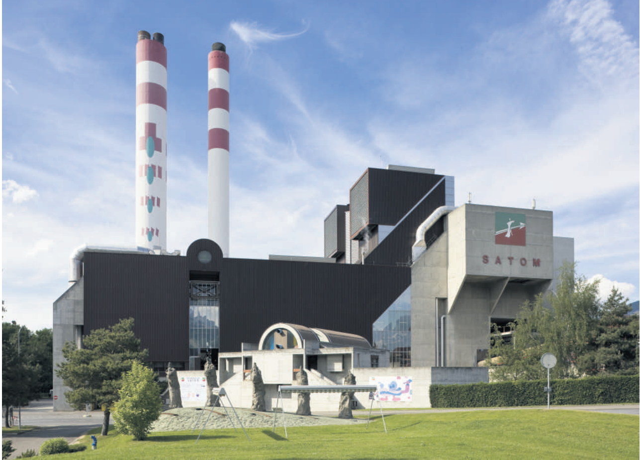
Kehrichtverbrennungsanlage Satom SA in Monthey.
