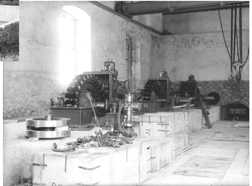
Montage der Turbinen im Jahr 1900
