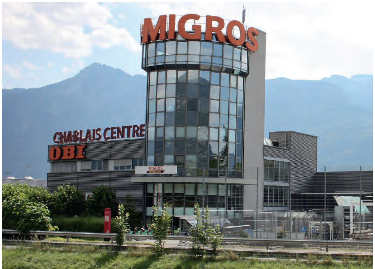
Le Chablais Centre Migros d'Aigle vient notamment de moderniser l'automation du chauffage, de l'aération et du refroidissement afin de passer de la classe D à la classe B. Ce projet sera présenté dans le cadre d'un séminaire organisé à Genève le 27 avril et présenté en page XX.
