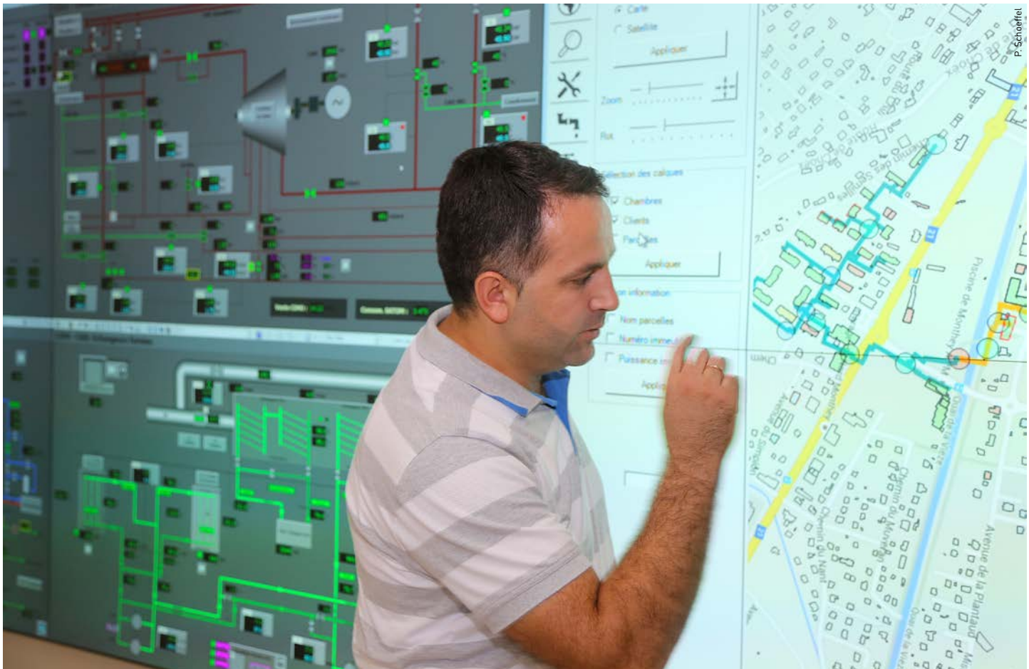
Mentor Ilazi, Ingénieur responsable du thermoréseau SATOM, dans la salle de commande.
